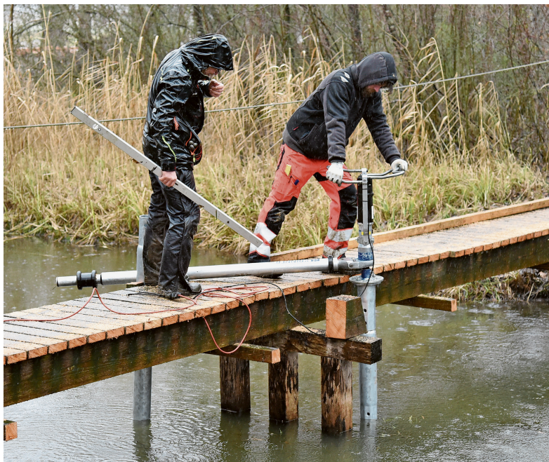
Arbeiter schrauben die Stahlpfosten für den Steg ins Wasser, nachdem die alte Brücke zur Hälfte entfernt wurde. Bild: cs
